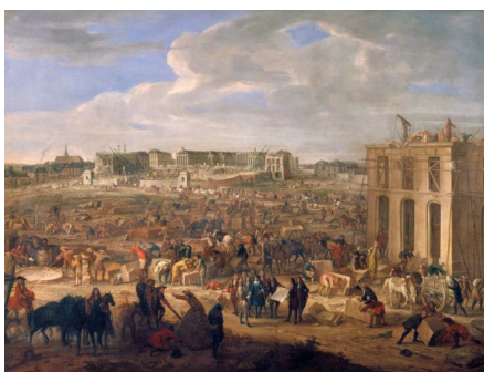
Pendant la construction
